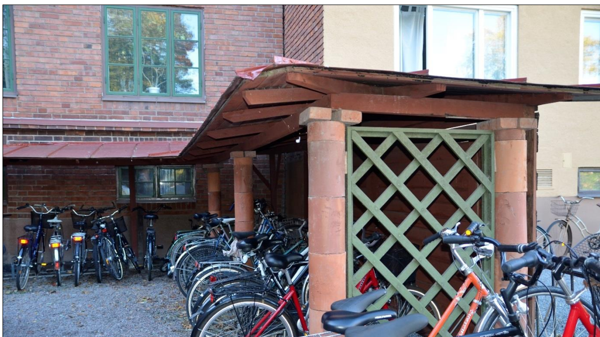
Cykelstall med dräneringsrör i tegel och tegelstenar som stöd för takbjälklaget och det falsade plåttaket Foto: Agnetha Pettersson, 2018
