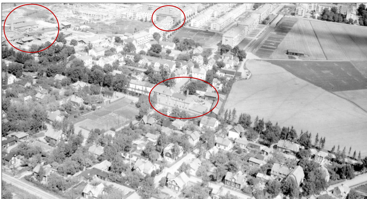
S:t Erikshuset i kvarteret Hjalte ovan, fd S:t Eriks Kakelfabriks fabrikslokaler i kvarteret Astronomen nedan till höger samt S:t Eriks tegelbruk i kvarteret Grenen ovan till vänster Foto: AB Flygtrafik, 1947
