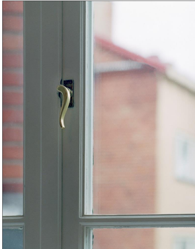
Fönstervred som återfinns på alla bostadshusets fönster och på balkongdörrarna
