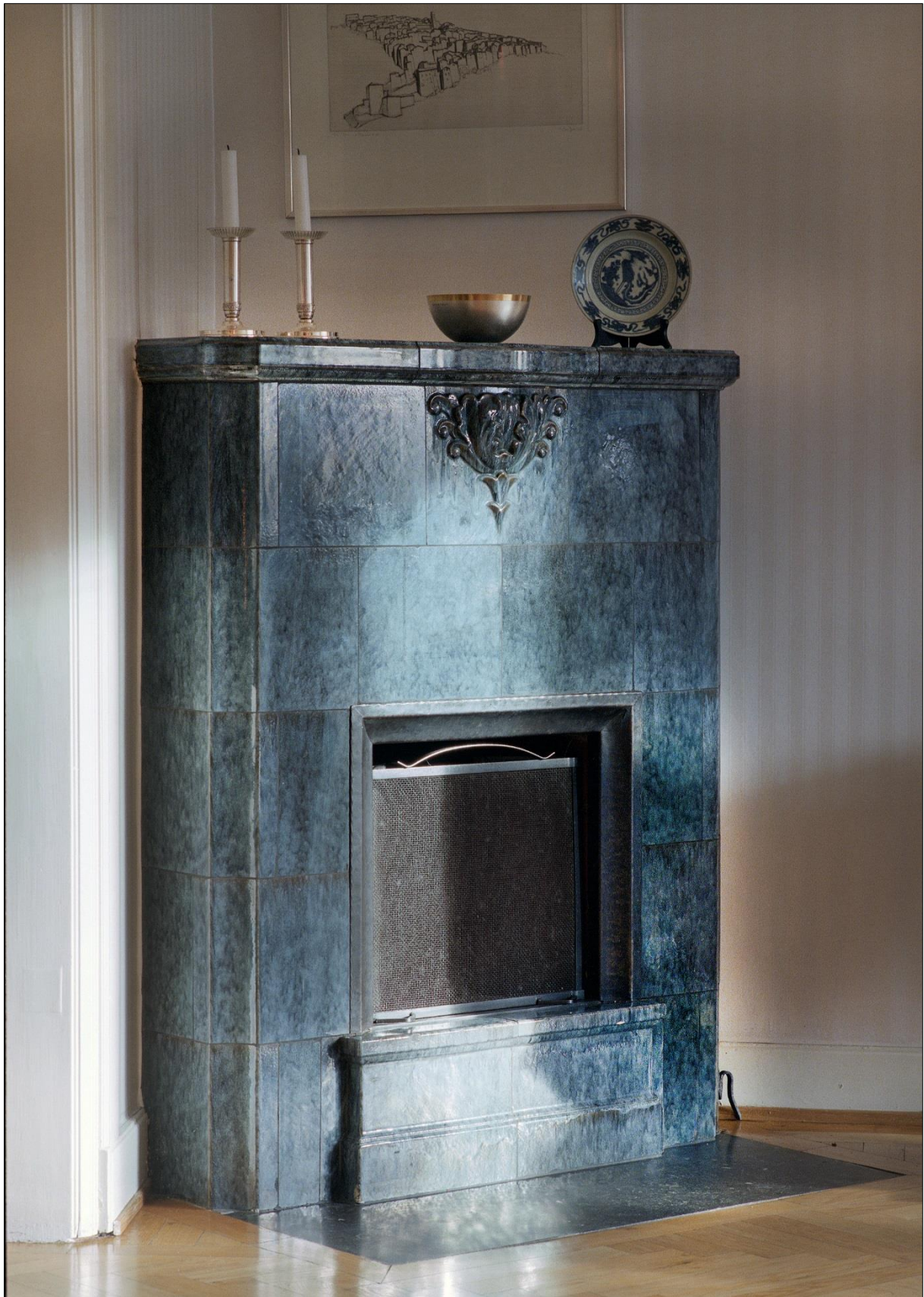
Öppen spis med kakelplattor med flammig konstglasyr och relief. Reliefen har nummer Nr 173 i företagens katalog. Eldstadsram i handsmitt järn. Spisen kunde som här placeras i hörn, eller anpassas för en slät vägg
