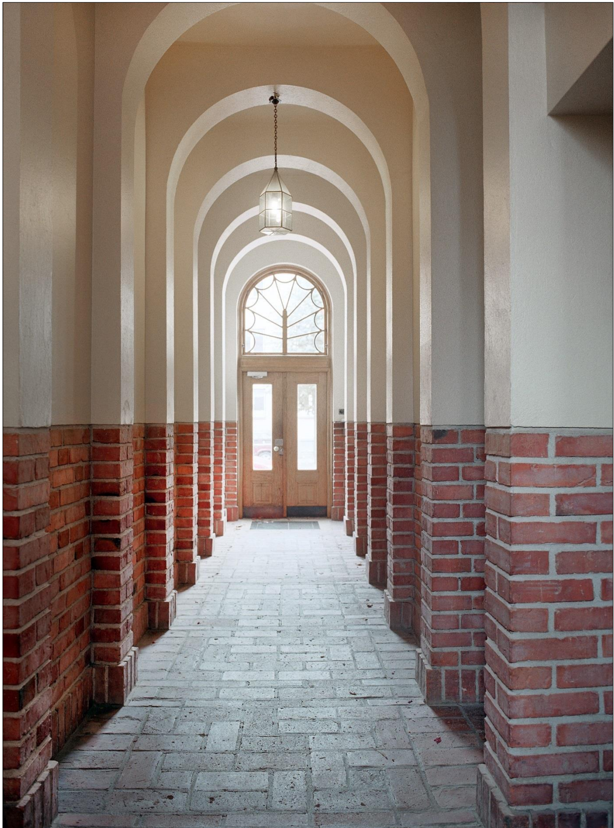
Entréhall under rundbågiga valv innanför huvudentrén mot Geijersgatan. Väggarnas nedre del och valvbågarnas sockel är utförda i rött murtegel. Golv med mönsterlagt rött storstenstegel
