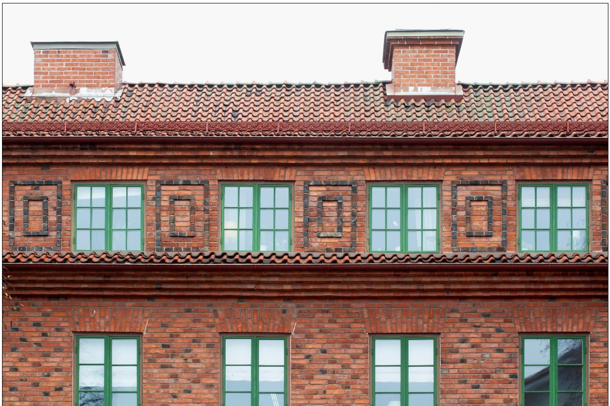
Fasad mot Viktoriagatan med fasadtegel från olika bränningar, mönstermurning ovanför fönstren, rektangulära reliefer i tegel i vindsvåningen och profilerad takfot
