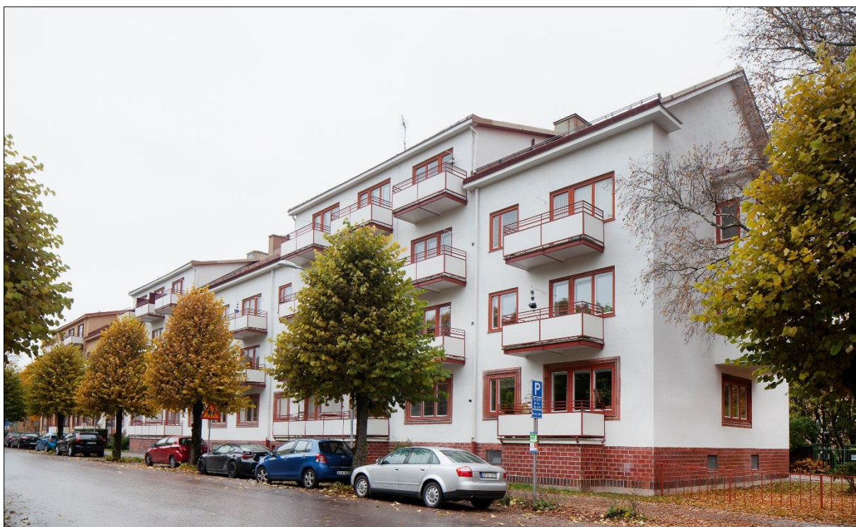
Flerbostadshus på Geijersgatan 44 A – B och 46 A – B i kvarteret Ejvind, uppfört av Brf. Viktoria, bildad 1939. Fönstren i bottenvåningen inramas av omfattningstegel från S:t Eriks Lervarufabrikers produktion
