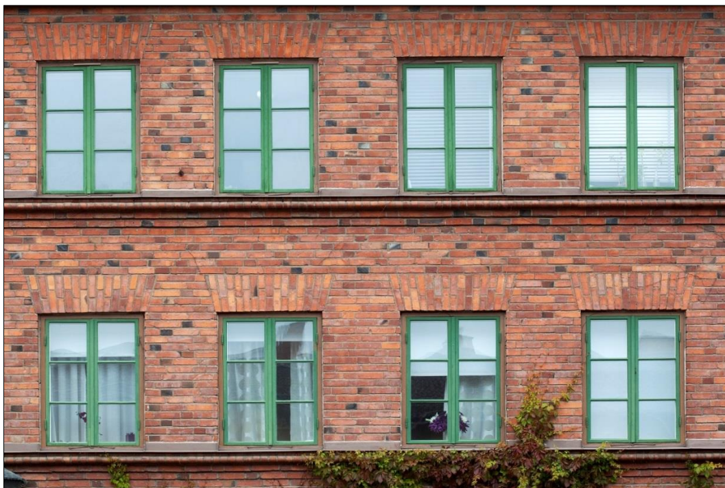
Originalfönster, kopplade och utåtgående i två lufter på fasaden mot Geijersgatan. Fönsterbågar, fönsterkarmar, fönsterbleck och lister målades om 2013 – 2014
