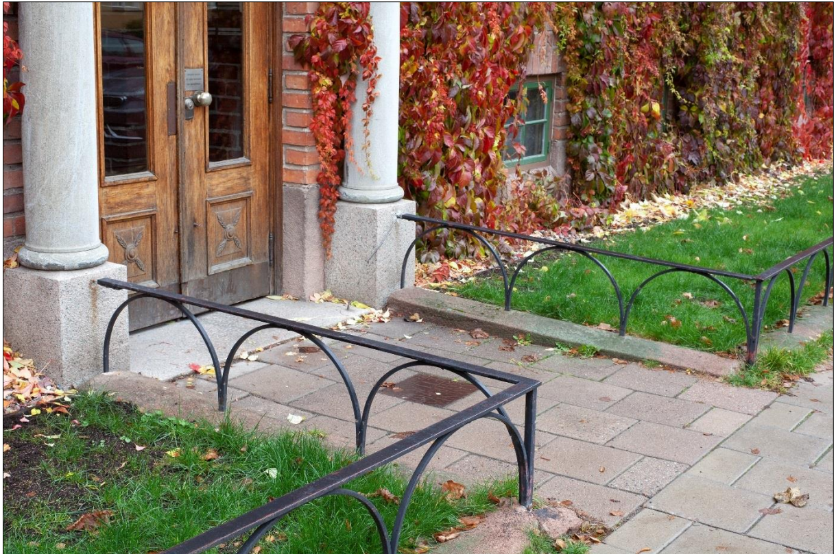
Smidesrücke mellan trottoar och förgård, gjutna plattor mellan trottoar och portens granittröskel
