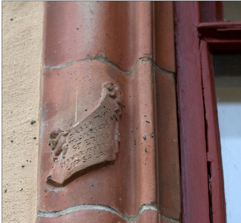
Inskription på skulpterat omfattningstegel tillhörande fönster på entrédörrens vänstra sida berättar att teglen tillverkats av S:t Eriks Lervarufabriker Uppsala
