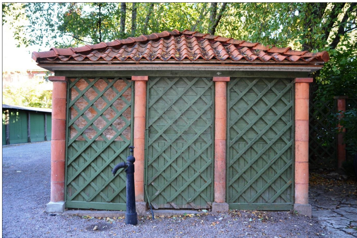
Sophus med stödpelare av dräneringsrör i tegel och tegelstenar som stöd för takbjälklaget och taket. Svagt utsvängt tälttak med enkupiga lertegelpannor och nockpannor Foto: Agnetha Pettersson, 2018
