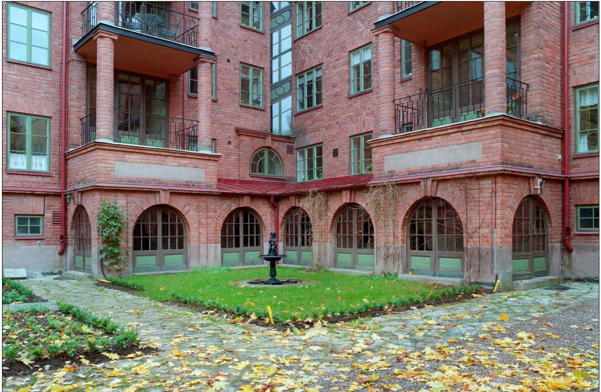
Trädgården med nyplanterat växtmaterial, 2005. Fontänskulptur i smide och i bakgrunden arkadgångens två dörrar med mellanliggande fönster, och ovanför arkadgången trapphusbalkongerna tillhörande uppgång C till vänster och uppgång B till höger. Putsade blinderingsfält på balkongstaplarnas nedre del
