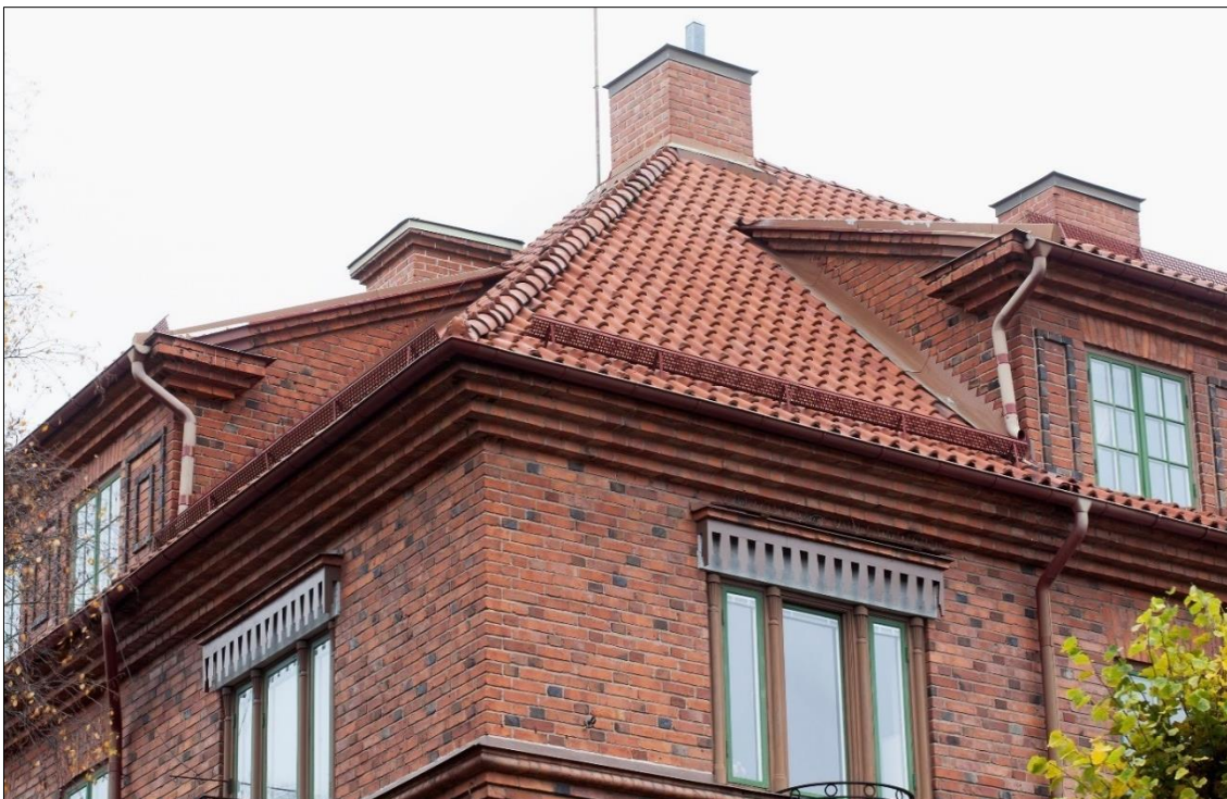
Parti av taket i hörnet av Viktoriagatan och Geijersgatan, med enkupiga lertegelpannor ochnockpannor övernockarna
