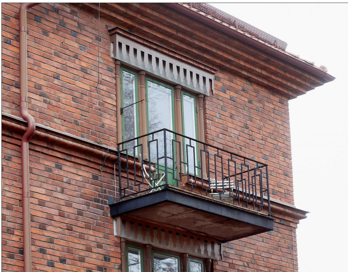
Balkong på fasaden mot Viktoriagatan med smidesrücke, flankerande kolonnetter i trä med kapitäl i anslutning till fönster och balkongdörr, baldakiner i brunmålade klippplåt över balkongdörr och fönster
