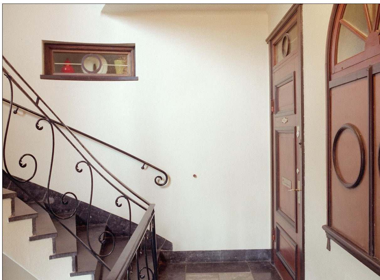
Uppgång A med lägenhetsdörr och fönsterlucka, betsade i brunt och med svartbrunt listverk. Rektangulära respektive lunettformat överljusfönster för indirekt belysning i kapprum och badrum/toalettrum, vilplan med marmorplattor, handledare och trapppräcken i svartmålat smide med graciös bladornamentik
