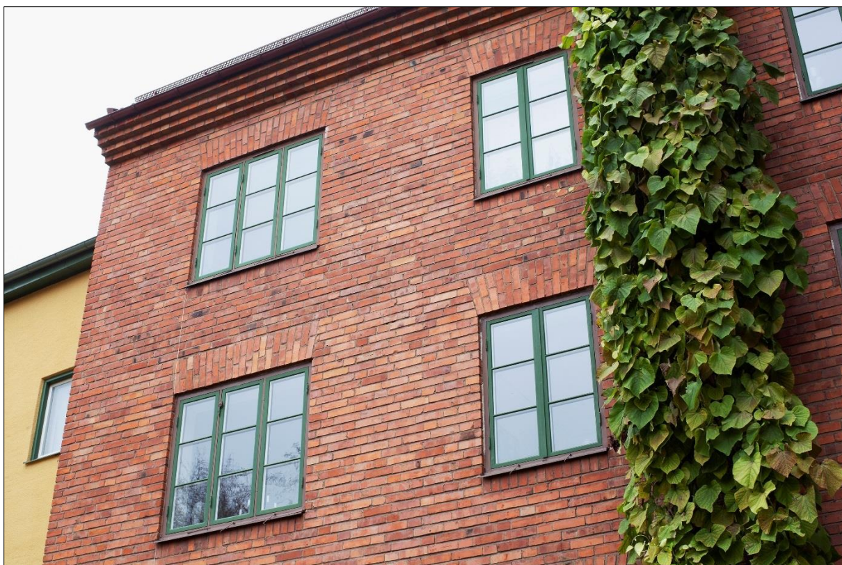
Kopplade utåtgående originalfönster i tre respektive två lugter på fasaden mot Viktoriagatan. Mönstermurning nedanför och ovanför fönstren samt profilerad takfot. Fönsterbågar, fönsterkarmar och fönsterbleck målades om 2013 – 2014
