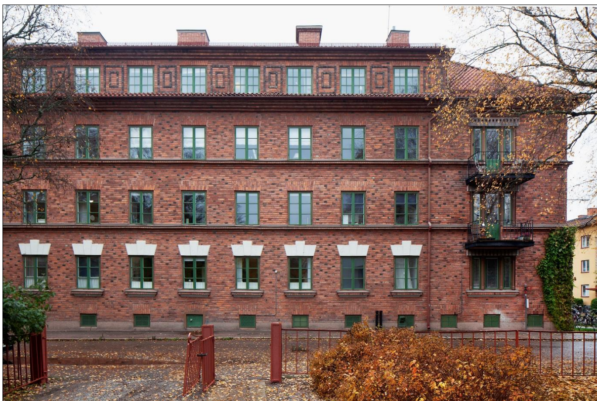
S:t Erikshusets fasad mot Viktoriagatan, med källarvåning, bottenvåning, våningsplan 1 och 2 trappor samt indragen vindsvåning. Innanför balkongerna återfinns det som på planritningarna benämns sällskapsrum
