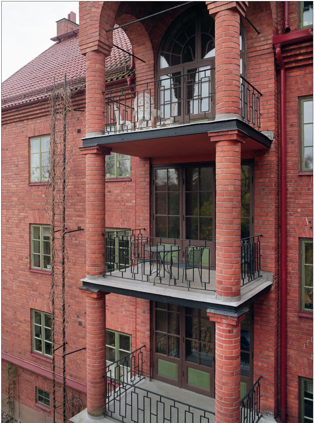
Balkonger i anslutning till trapphus C, med kolonner i rundformtegel krönta av en hög valvbåge, fönsterdörrar med spröjsindelning, svartmålade smidesräcken
