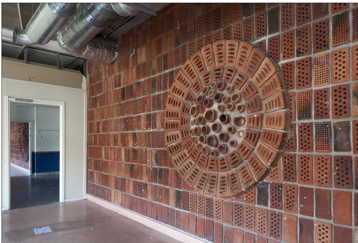
Korridor i Tiundaskolan före rivning, med Ingrid Atterbergs reliefer med håltegel och dräneringsrör ur S:t Eriks Lervarufabriks produktion Foto: Olle Norling, 2015
