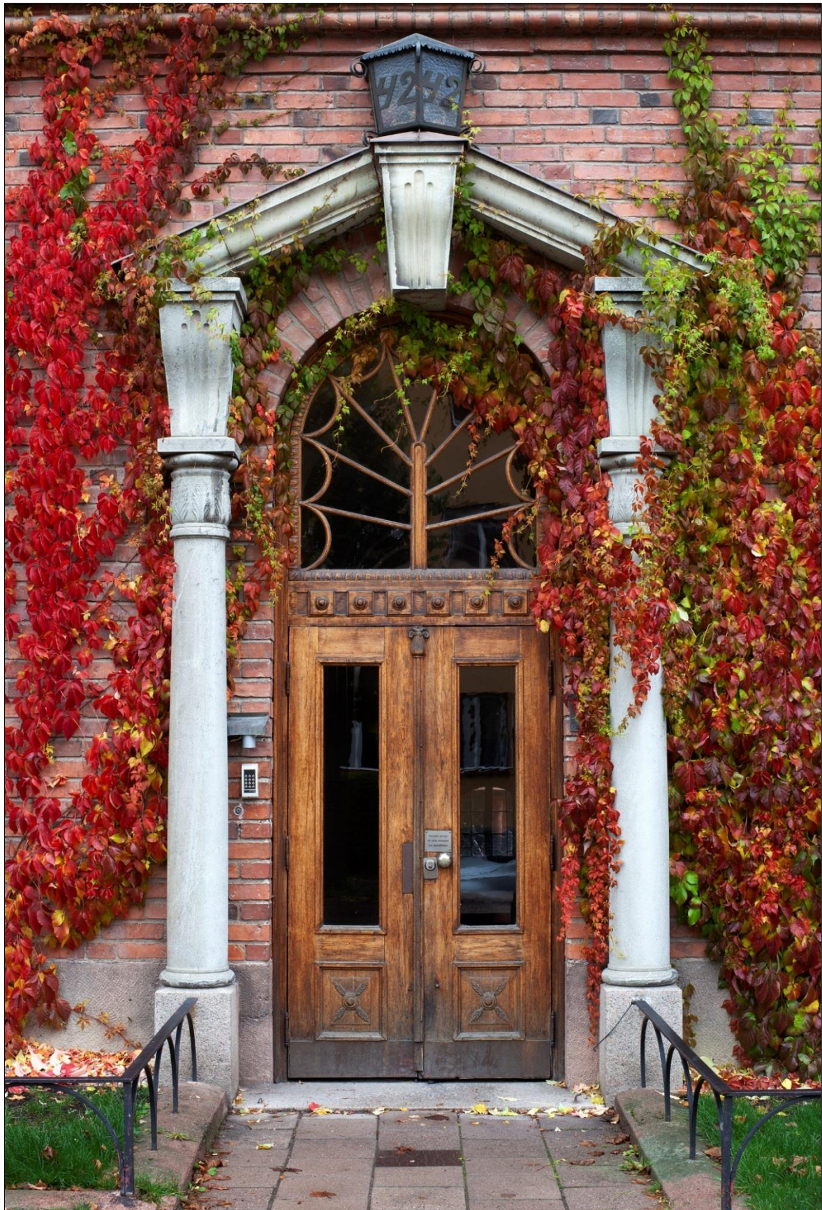
Porten mot Geijersgatan flankeras av en portal med kolonner på granitsockel, kapital och en tempelgavelformad kornisch. Ovanför porten finns ett högt rundbågigt överljusfönster med glas inom träspröjs
