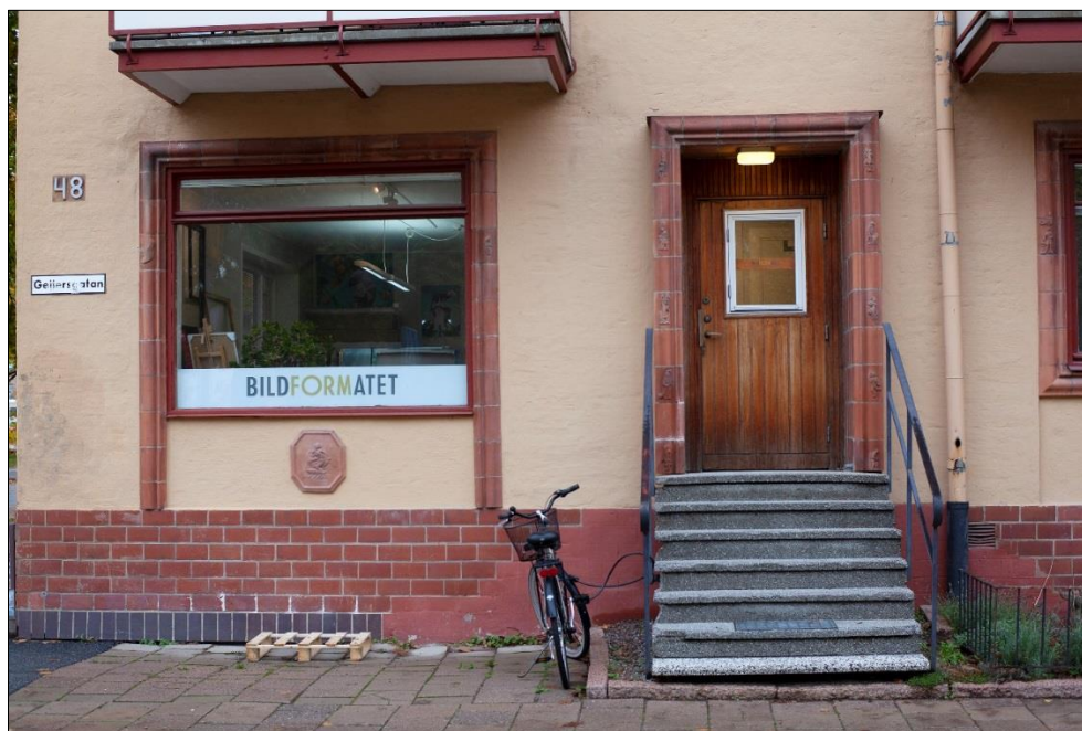
Entrén till AB S:t Eriks Lervarufabrikens tidigare kontor och visningsrum på Geijersgatan 48 B, med bevarat skulpterat omfattningstegel runt fönster och dörr, samt keramisk relief under fönster. På väggens sockel syns profilen efter den tidigare trappan i tegel
