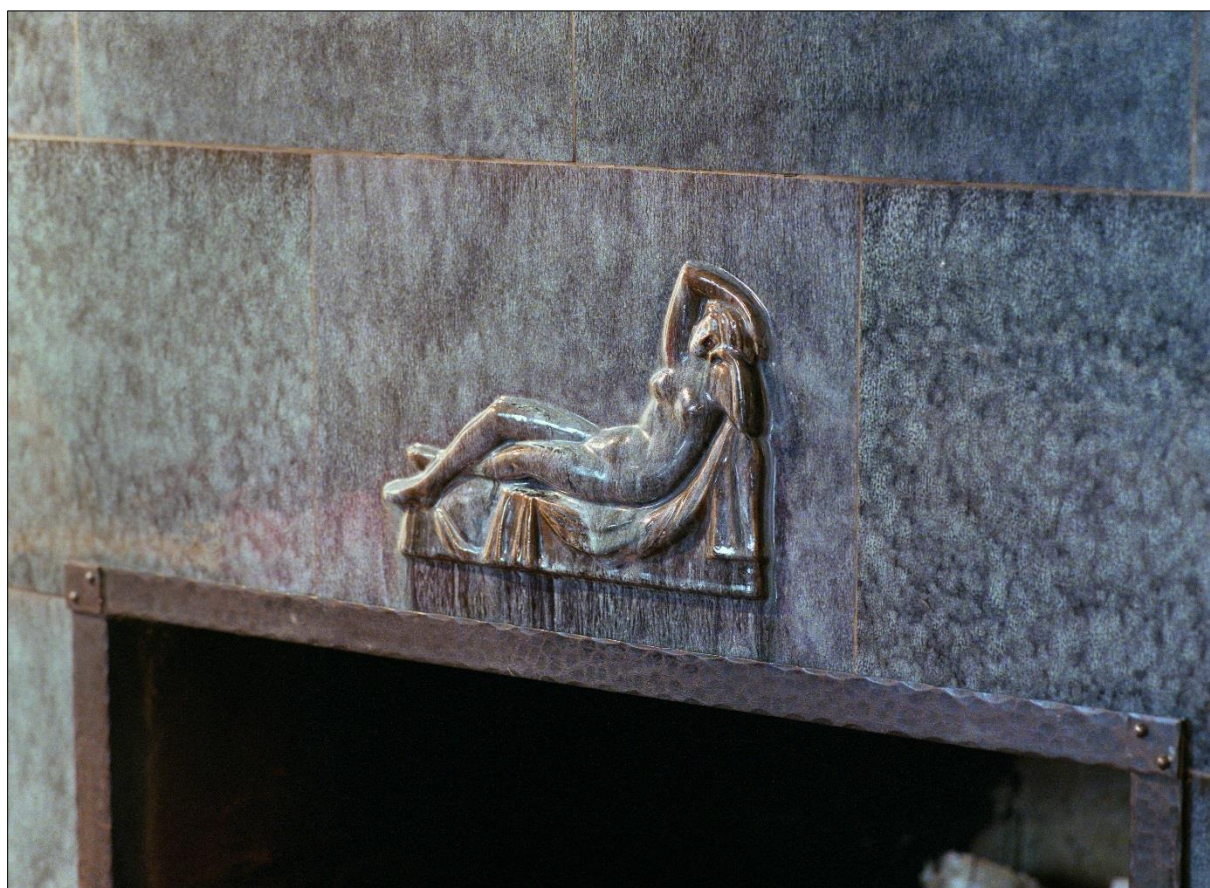
Hörnplacerad öppen spis med kakelplattor med flammig konstglasyr, relief och eldstadsram i handsmitt järn
